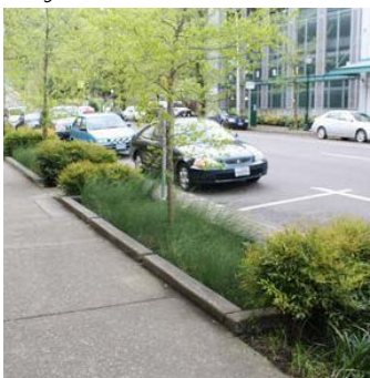
Séparation et infiltration, Portland.
