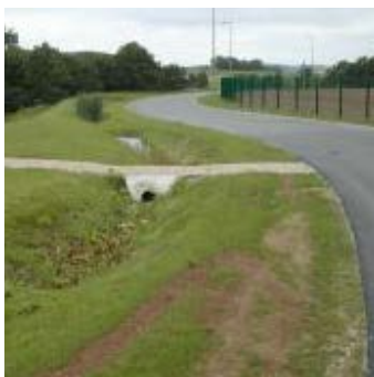
Noue engazonnée en bas coté de route.
